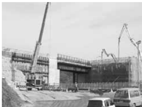
⑤の跨線橋工事
