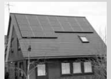
屋根に太陽光パネルを設置した一般住宅
