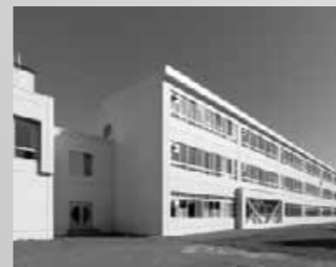
改修工事終了後の校舎
