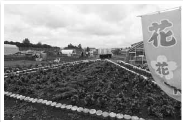
解体中のフラワー温室クラブ
