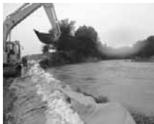
復旧作業中の芽室川
