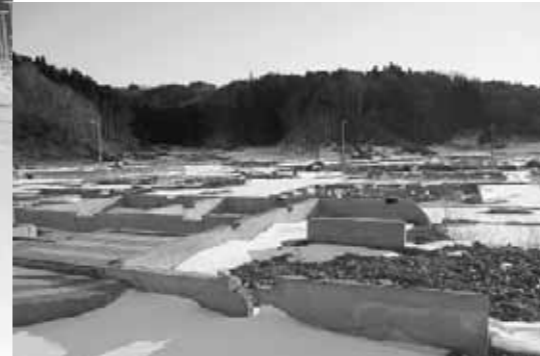
基礎だけ残る住宅地
