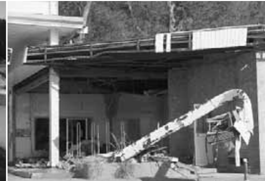
倒されたガソリンスタンドの鉄柱
