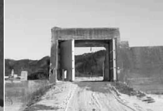
水門だけ残った防潮堤
