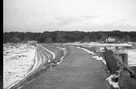
田老の防潮堤
