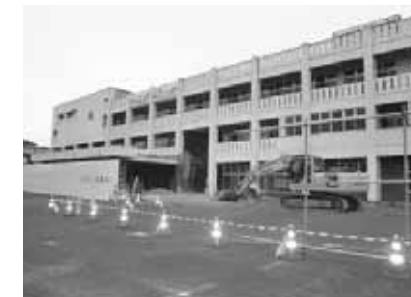
解体が始まった旧役場庁舎
