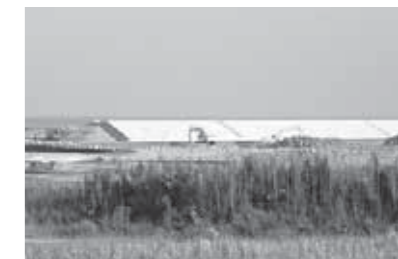
堤防工事(山元町)
