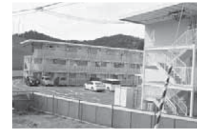
球場内の仮設住宅(女川町)
