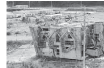
倒れたままの建物の様子(女川町)
