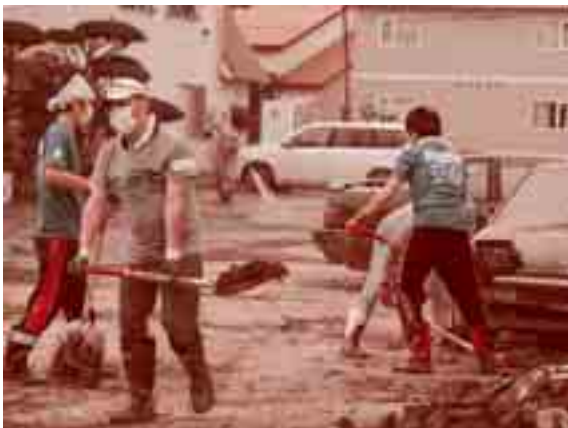
▲西町での汚泥処理の様子
