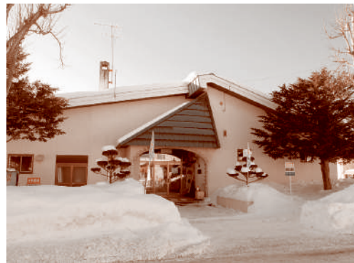
昭和52年に建てられた「弥生福祉館」
