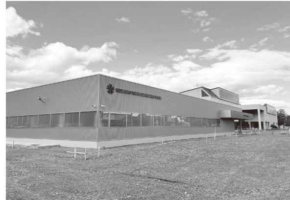
▲約1年の工事を経て、新しくなった温水プール
