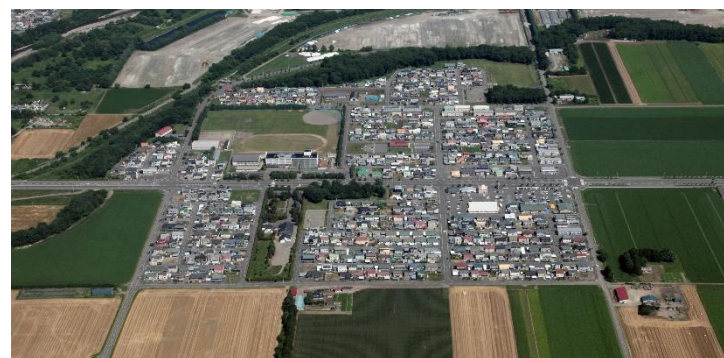
東芽室土地区画整理事業実施地域を南側上空から撮影
