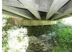
【下部工全景：橋台A2】
